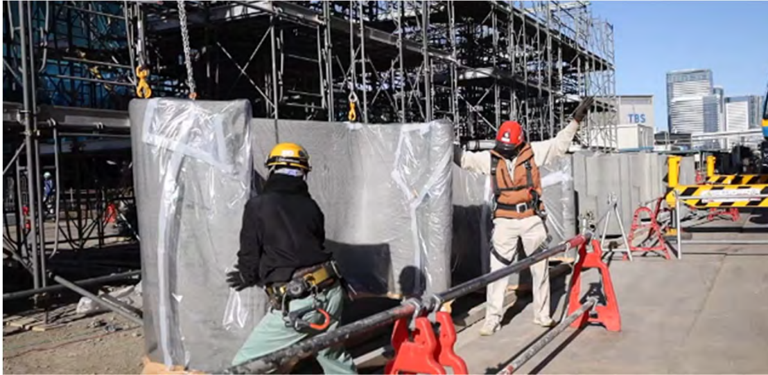
翌日から施工現場へ運搬可能
