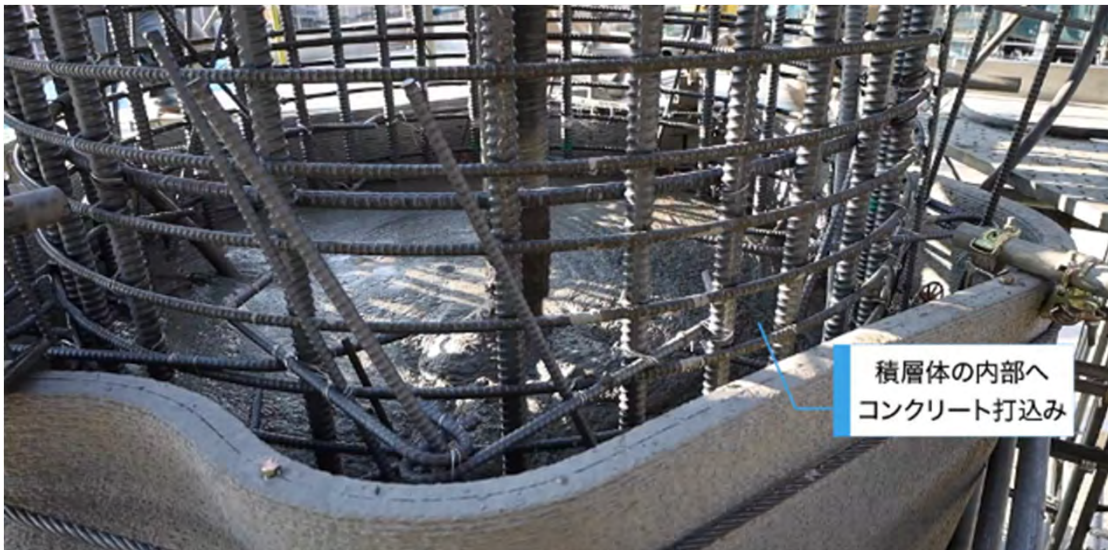
現場で積層体内部へコンクリート打込み
