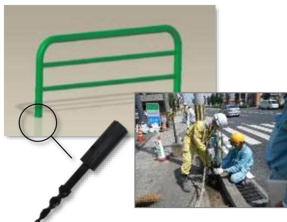
防護柵用基礎杭
