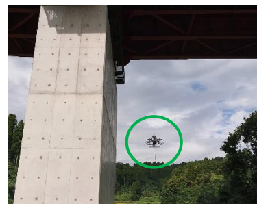
ドローンによる近接
