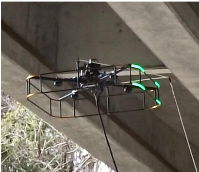
橋梁点検ドローン
