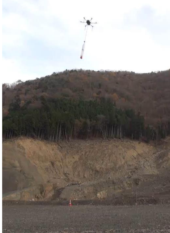
地すべり検知ノード投下の様子
